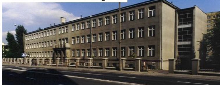
Budynek Gimnazjum nr 5 (wejście boczną klatką schodową), obok Akademii Muzycznej, Politechniki Śląskiej i Centrum Handlowego BELG.
